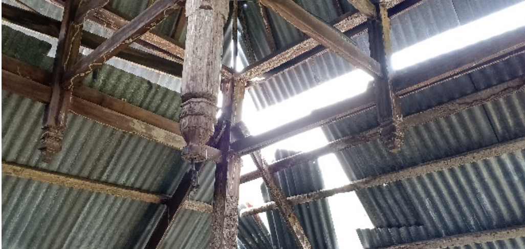
RAJAH 1. Buah buton tergantung pada seni bina tradisional di Luak Tanah Mengandung
