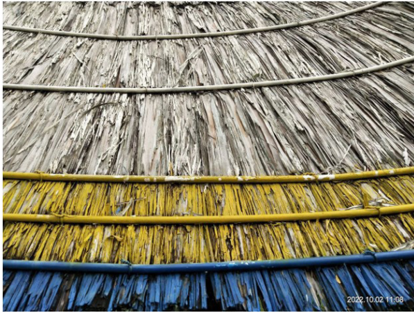
GAMBAR 9. Komponen kajang – daun rumbia, buluh Sumber: Kajian lapangan
